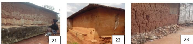
Photo 21, 22 et 23 : Construction de terrasses ou murettes et groupage de pierre contre l'érosion pluviale
