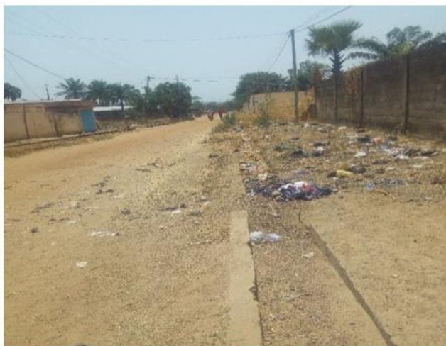
Photo 4 : Caniveau bouché à Tiwindè
