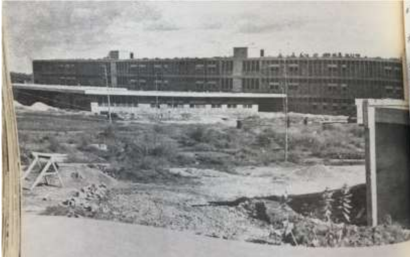
Photo n°3 : Le second hôpital de Ouagadougou en construction en (1959)
