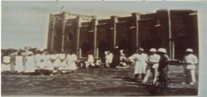
Photo n°1 : Vue partiel de l'hôpital de Ouagadougou
