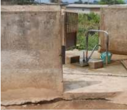
Photo 1 : Forage équipé de pompe manuelle
