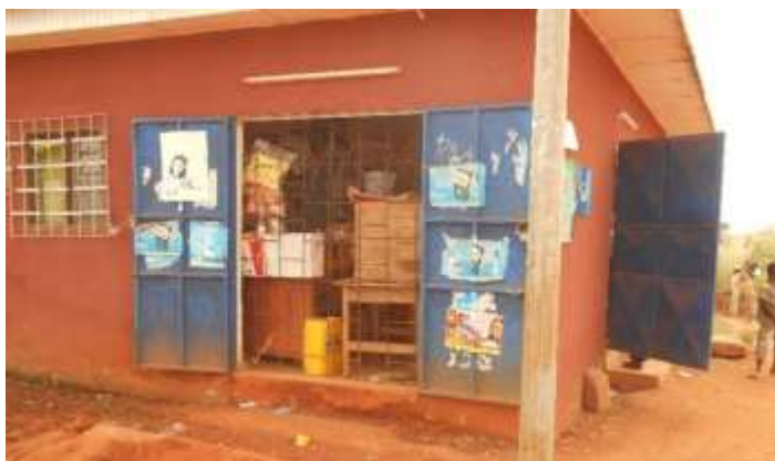
Photo 2: Boutique de quartier située à Tazibouo Plateau construite en matériau dur
