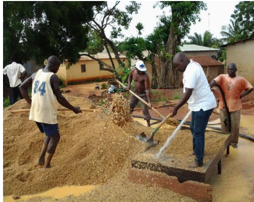
Lavage de gravier "tout venant"
