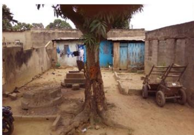
Photo VI: Une cour dans son état avant (2013)
